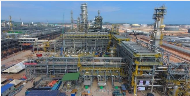
말레이시아, 정유 공장
