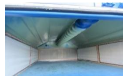
内側にスパイラルが入ったコンテナをロールオフ
